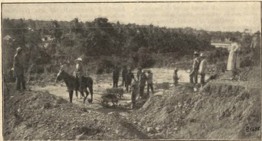
Don Balzola dirige i lavori di scavo delle fondamenta del tempio di Cuyabá (1911).
