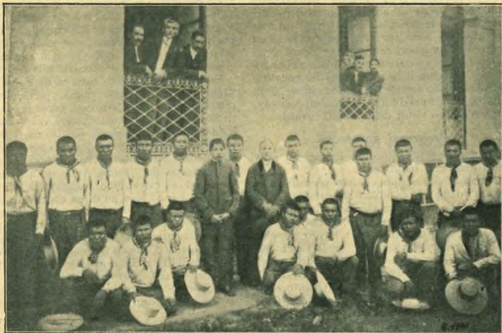
Bororos che scavarono le fondamenta del tempio di Cuyabá nel 1911.
